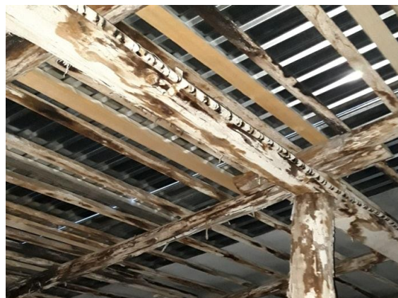
Рисунок 7 - Состояние кровли здания
