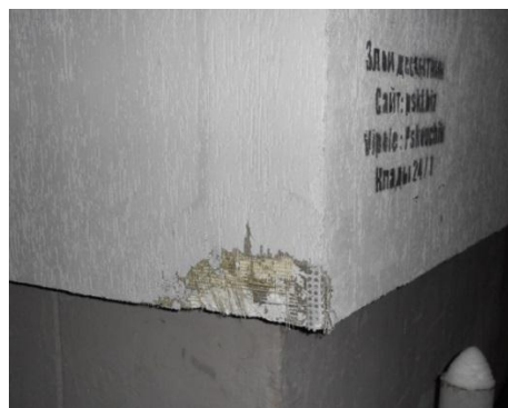
Рисунок 2 - Повреждения защитного тонкого слоя штукатурки системы теплоизоляции «мокрого» типа
