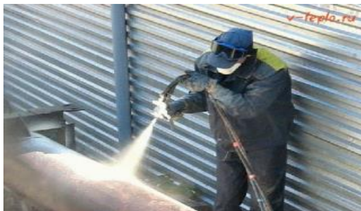
Рисунок 1 - Покрытие труб жидким утеплителем
