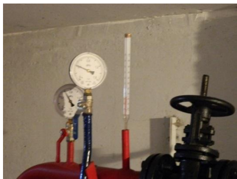
Рисунок 1 - Оборудование индивидуального теплового пункта многоквартирного жилого дома с отсутствием системы автоматического регулирования
