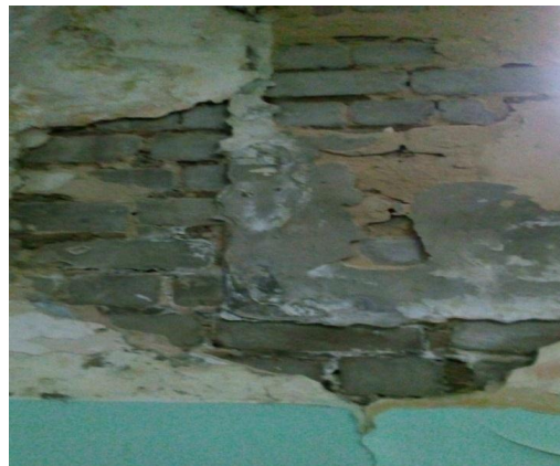
Рисунок 3 - Деструкция кирпичной кладки и разрушение штукатурного покрытия стен
