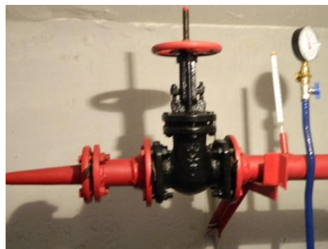
Рисунок 1 - Оборудование индивидуального теплового пункта многоквартирного жилого дома с отсутствием системы автоматического регулирования
