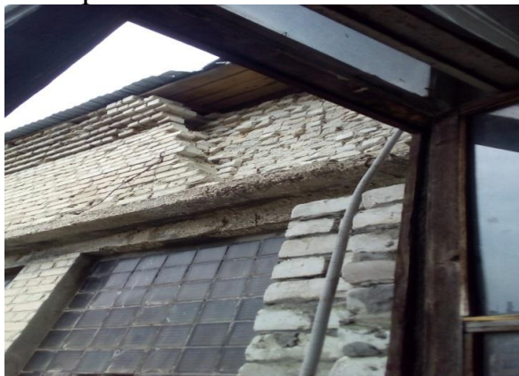
Рисунок 3 - Деструкция кирпичной кладки и разрушение штукатурного покрытия стен
