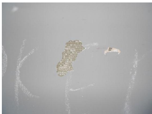
Рисунок 2 - Повреждения защитного тонкого слоя штукатурки системы теплоизоляции «мокрого» типа
